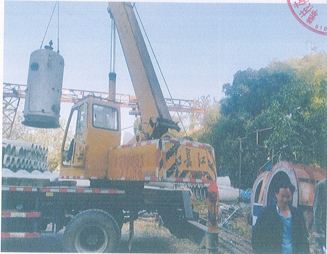
三、正在对拆除的燃煤锅炉作废毁处理
