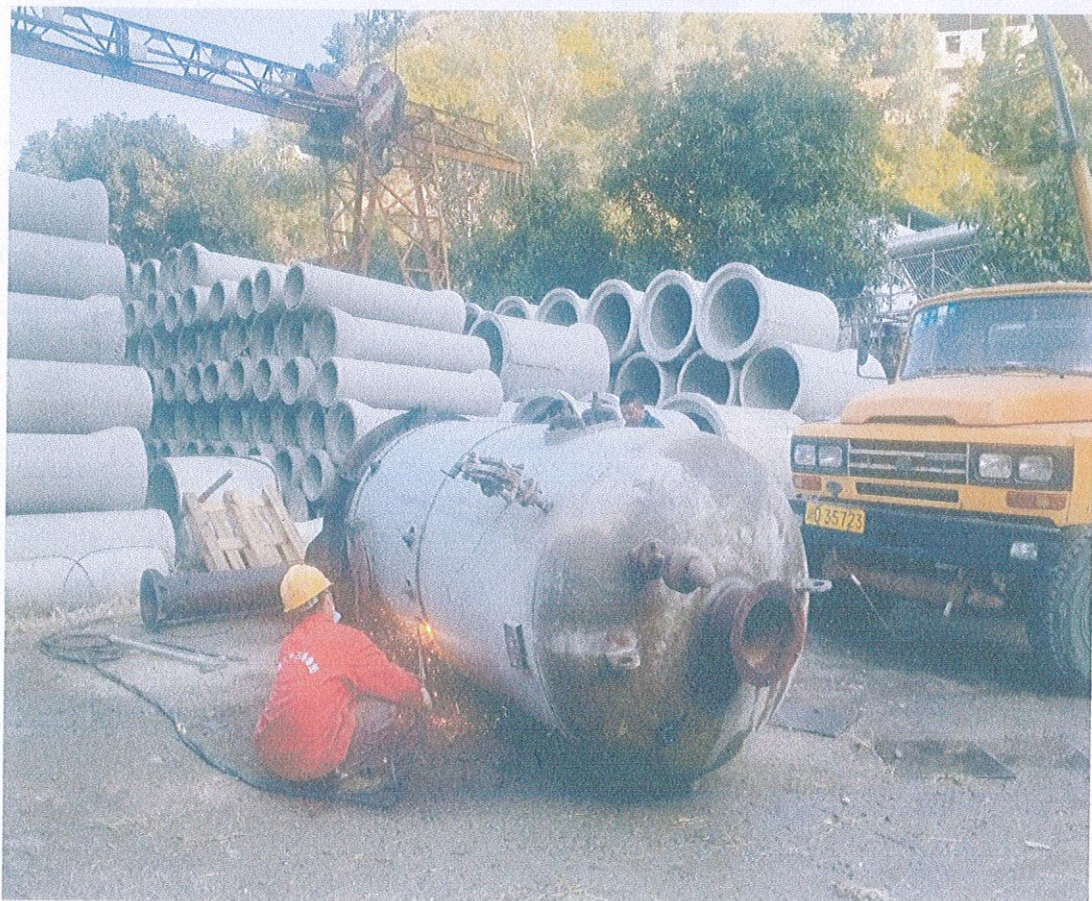
三、正在对拆除的燃煤锅炉作废毁处理
