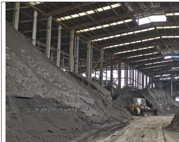
原料钒渣堆场
